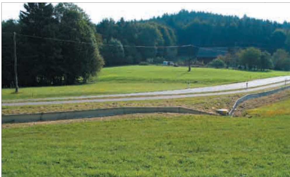
Tunnel-Leit-Anlage im Bereich Wukschteich, Gemeinde Schiefeling am See (Foto: Martin Jandl).
