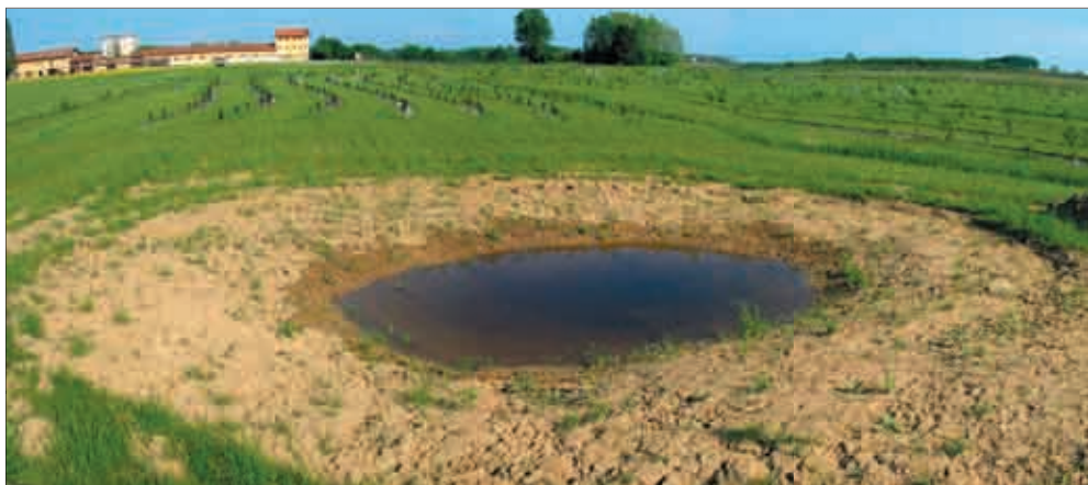
Panoramica della pozza impermeabilizzata con "Bentomat" a Palazzolo dello Stella (UD) - foto Sergio Cavan.
