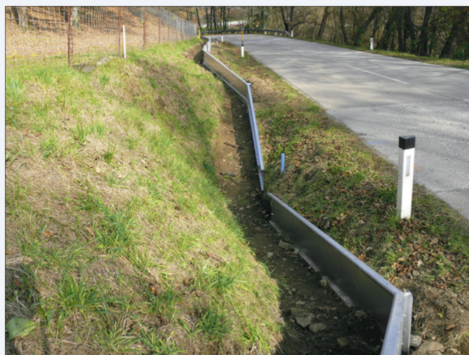
Einbau Metallleitwand (2010 und 2011).
