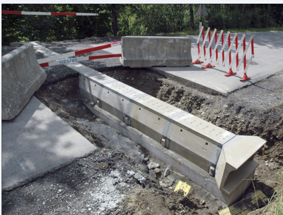
Einbau ACO-Tunnel (2007)
