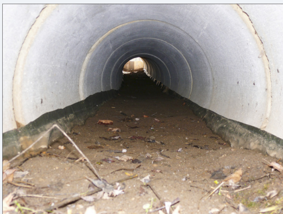
Betonrohr mit Folie und Erde (2008)
