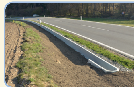
fertig gestellte Leitwand mit Umkehrelement (07.04.2020)
