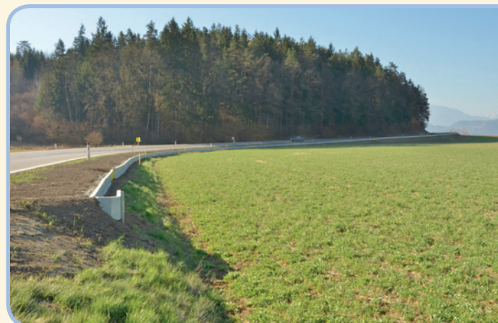
fertig gestellte Leitwand (07.04.2020)
