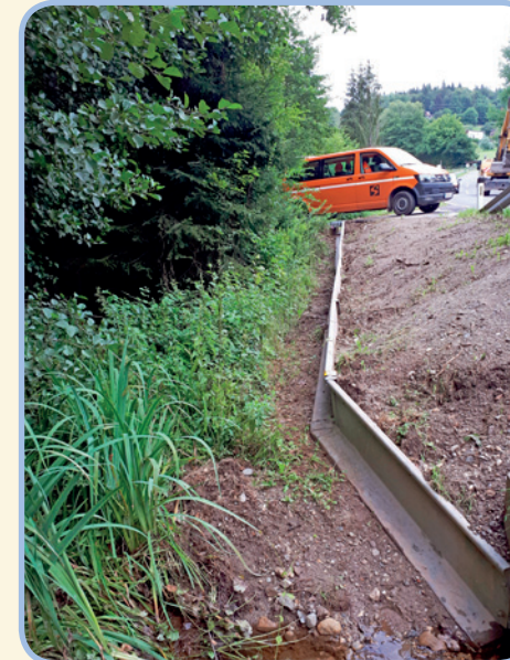
AW 103 nach der Sanierung (06.08.2020)
