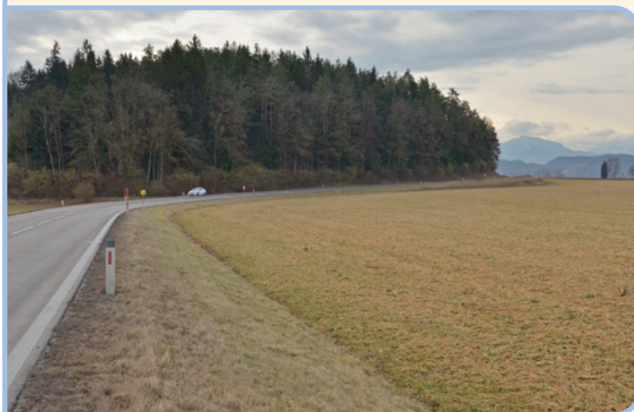
Situation vor Einbau der Leitwand (19.02.2020)
