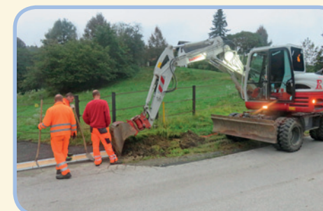
Bau der Verlängerung (29.09.2020)
