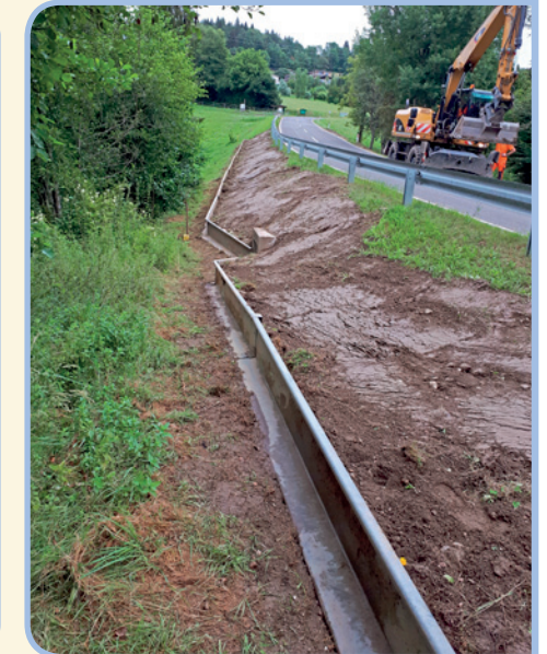
AW 103 nach der Sanierung (06.08.2020)
