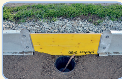
zur Amphibienwanderzeit verschlossene Leitwand-Lücke mit Kübel (07.04.2020)
