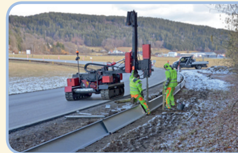
Einbau der Leitelemente (28.02.2020)
