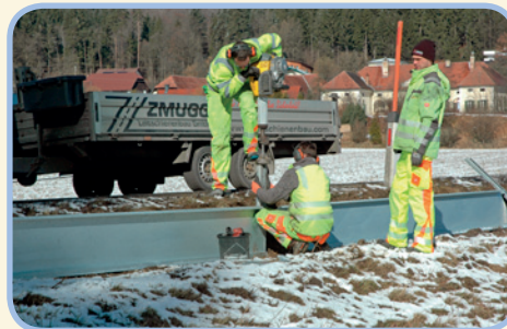
Einbau der Leitelemente (27.02.2020)
