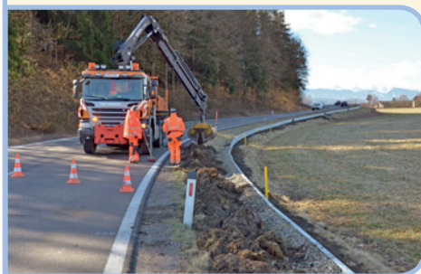
Hinterfüllung der Leitwand (11.03.2020)
